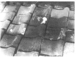
写真1 屋根瓦の腐蝕
