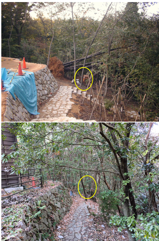
写真-1 造成工事直後と現在の林内の様子 (上：2004.11.12、下：2023.12.18)
