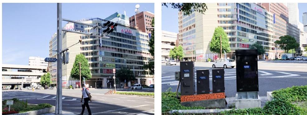
図2 笹島交差点のバックアップ電源付信号機（左：本体、右：バッテリー）
