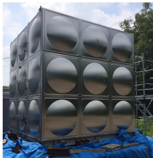
写真-3 ステンレス鋼製パネルタンク
