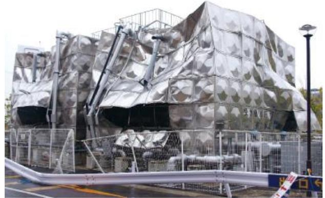
写真-1 ステンレス製貯水タンク破損<sup>6)</sup>
