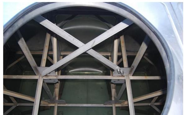
写真-8 タンク補強材追加例 (1案)
