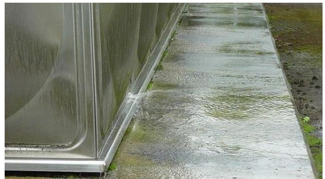
写真-2 パネル接合部での漏水<sup>6)</sup>
