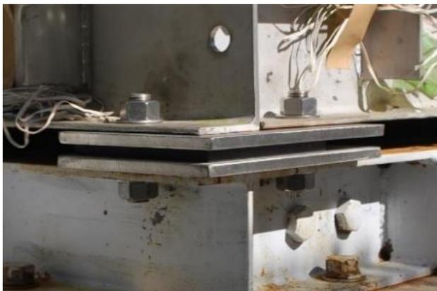
写真-7 制振装置を設置した様子
