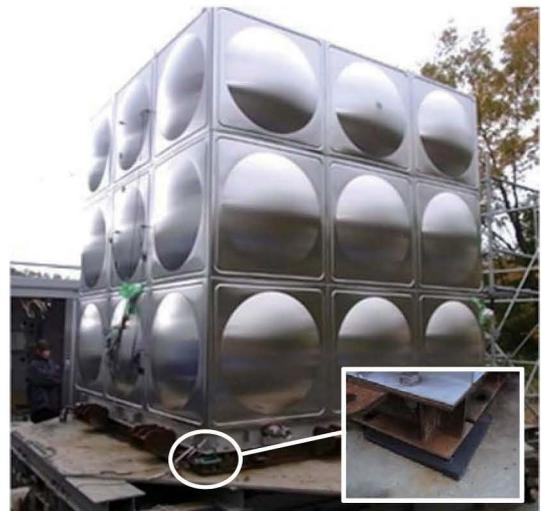
図-1 ステンレス鋼製矩形槽
