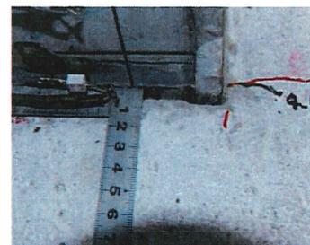
写真-1 根巻コンクリート上部に発生した隙間
