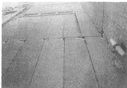
写真 3.4 長町劇場, ALC パネルの隅角部が欠けている
