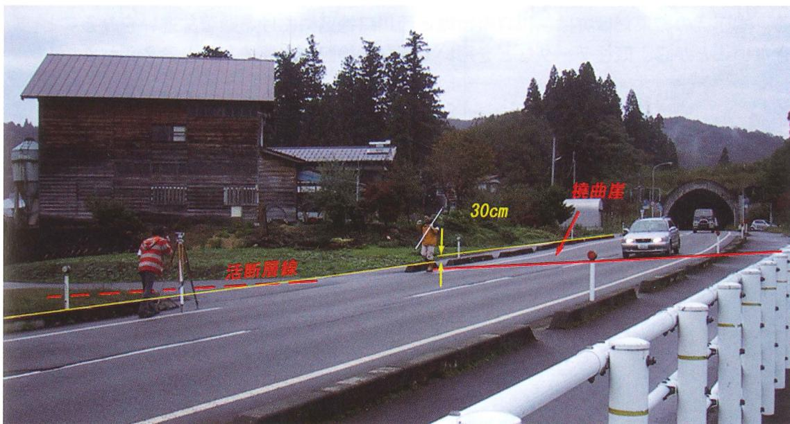
新潟県中越地震で活動した小平尾断層によって変位した道路面。赤い線から写真奥側が約30cm 撓み上がった。(鈴木・渡辺・廣内、2004) より引用
